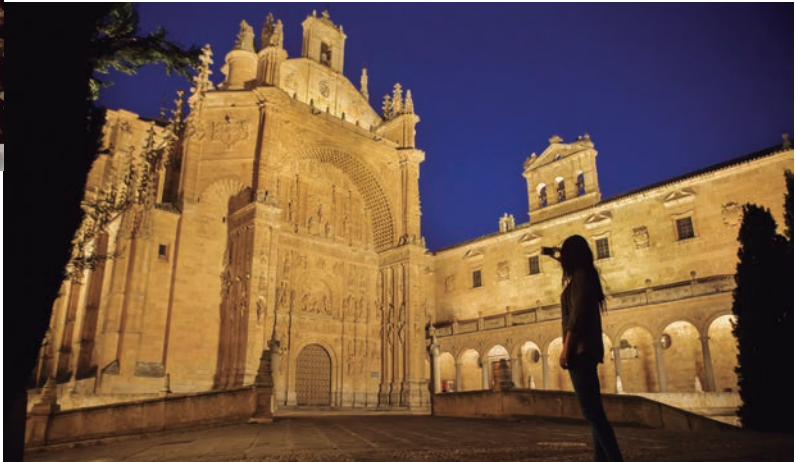
Fachada desde plaza del Concilio de Trento
